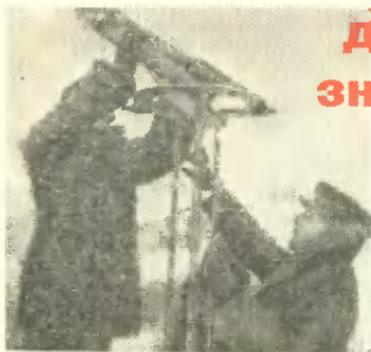
Установка двухступенчатой ракеты в пусксовом станке. Справа — конструктор И. А. Меркулов
