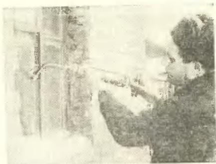
цы сконных переплетов. С помощью такого устройства за смену он промазывает 2 тысячи погонных метров фальца — работа четырех стекольщиков, выполняющих то же, но вручную.
