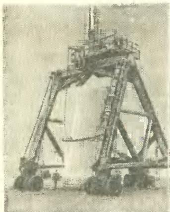
сам, давно уже не диовинка. А на этом фото вы видите немецкий самоходный мостовой кран, передвигающийся на 12 резиновых пневматических шинах больших размеров. Такой кран способен транспортировать значительные грузы на большие расстояния, не будучи связан с рельсовой колеи. На снимке кран поднимает и перемещает бетонные трубы громадного диаметра, весом по 90 тонн каждая.
